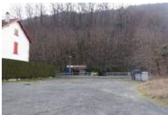
La halte ferroviaire - Source : APGL
