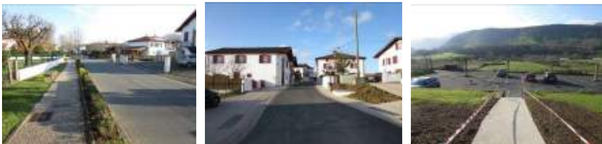
Cheminement entre la mairie et le trinquet Espaces publics réaménagés Cheminement doux vers le parking créée
