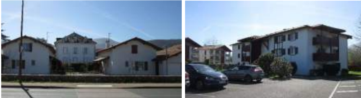
Vues sur l'opération Xapata-Beltxa et ses logements collectifs (source : APGL64)
