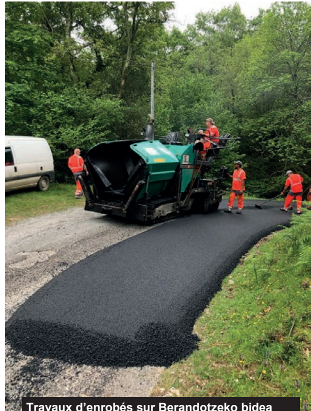
Travaux d'enrobés sur Berandotzeko bidea
